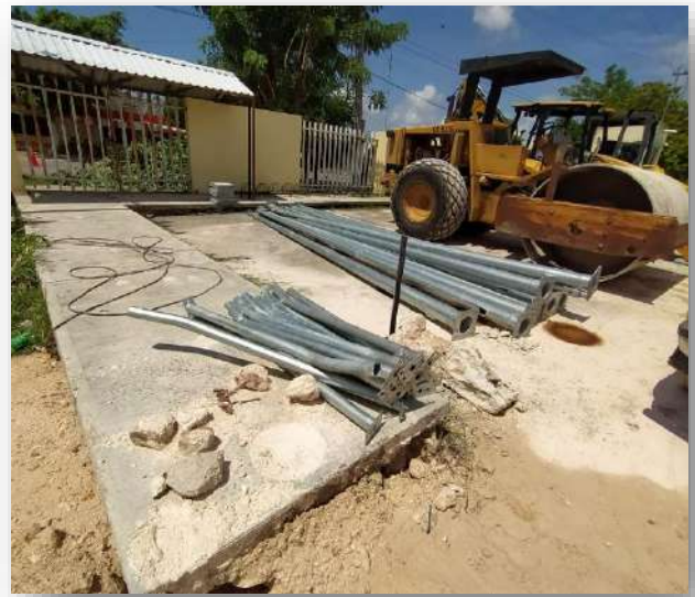
Instalación de Iluminaria
