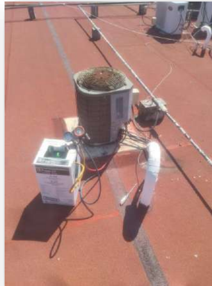
Mantenimiento a equipos de Aire Acondicionado Edificio W
