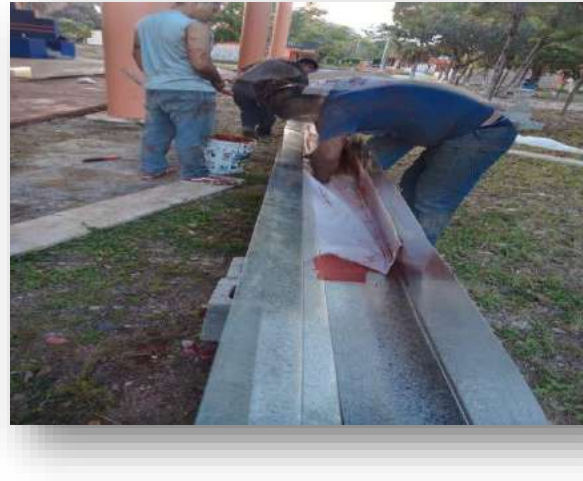
Mantenimiento al Canalón en Domo del Instituto
