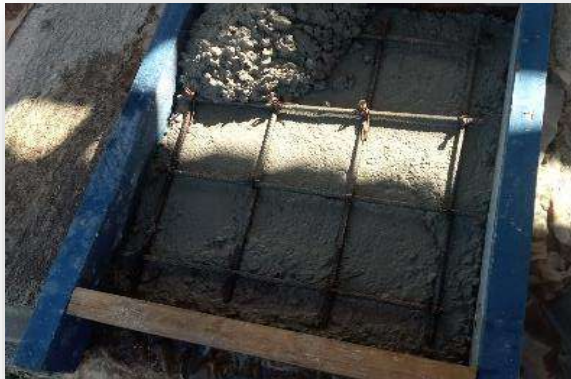
Mantenimiento de Tapas de Concreto de Registros Eléctricos
