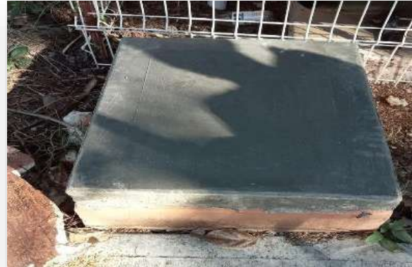
Mantenimiento de Tapas de Concreto de Registros Eléctricos
