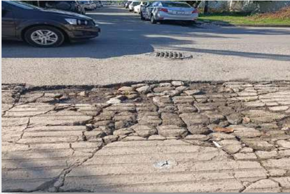
Mantenimiento de Rampa de Concreto de Acceso a Estacionamiento de Alumnos
