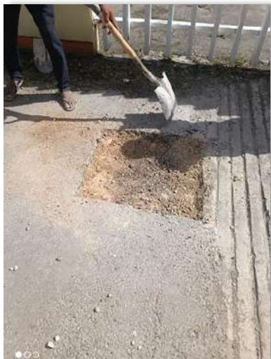
Mantenimiento correctivo, bacheo del estacionamiento de personal, acceso por Av. Insurgentes.
