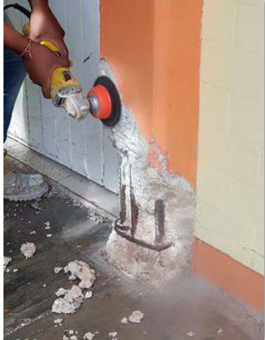
Mantenimiento correctivo, reparación estructural de columnas del Edificio C.
