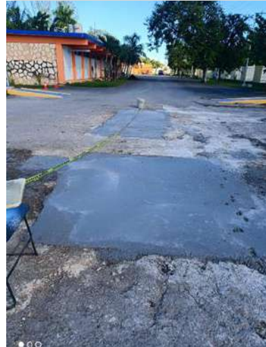
Mantenimiento correctivo, bacheo del estacionamiento de alumnos, acceso por calle Juan José Siordia.
