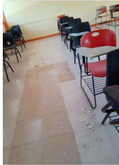
Mantenimiento al piso en aulas del edificio C
