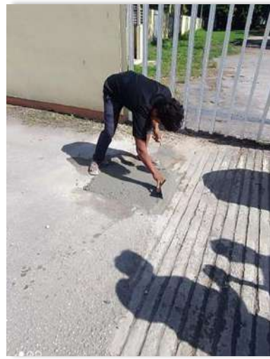
Mantenimiento correctivo, bacheo del estacionamiento de personal, acceso por Av. Insurgentes.
