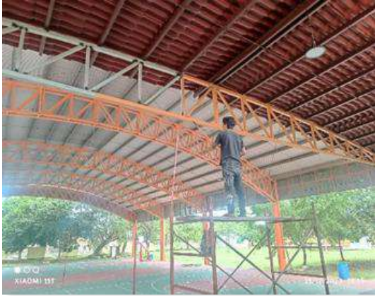
Pintura de esmalte a las estructuras del escenario.
