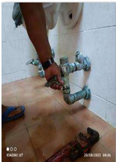
Mantenimiento a los accesorios hidráulicos de los baños del edificio W.
